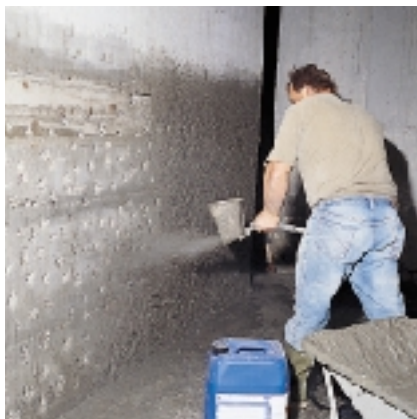
Aplicación a chorro de la 1ª capa de mortero aditivado con IDROSILEX LIQUIDO
