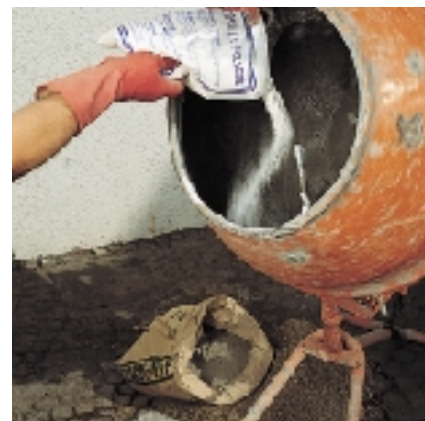
Preparación del mortero hidrófugo aditivado con IDROSILEX POLVO
