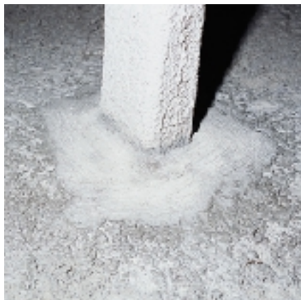
Ejemplo de una columna impermeabilizada con IDROSILEX
