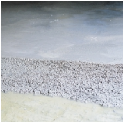
Cimiento de hormigón aditivado con IDROSILEX
