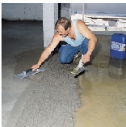
Aplicación del batido del pavimento aditivado con IDROSILEX LIQUIDO
